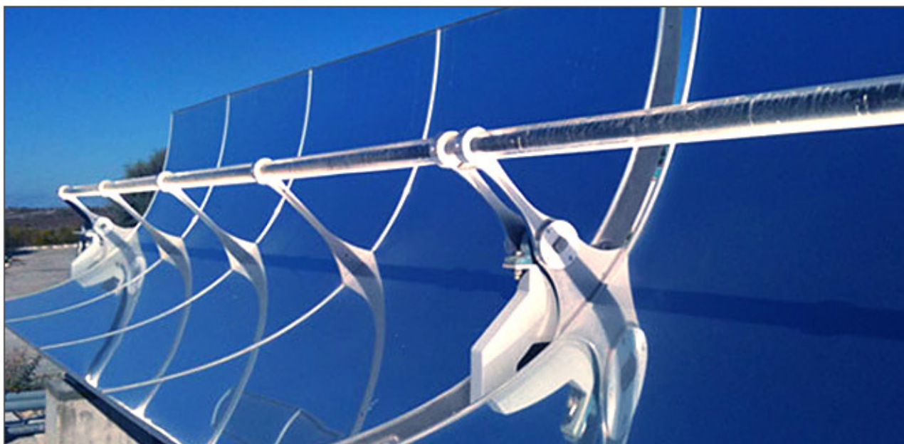
Рис. 9. Параболический солнечный концентратор
